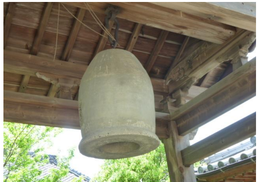
コンクリート製の梵鐘
