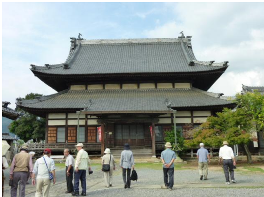
屋根が二層の本堂
