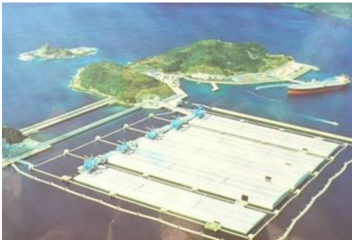
洋上の石油備蓄基地
