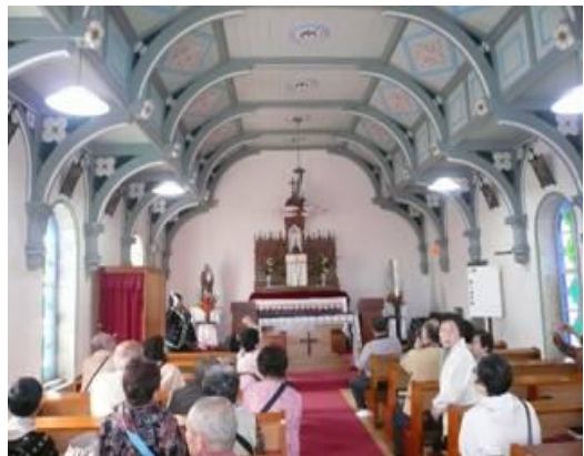
船底天井の室内
