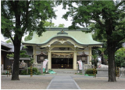
鉄筋コンクリート製の本殿
